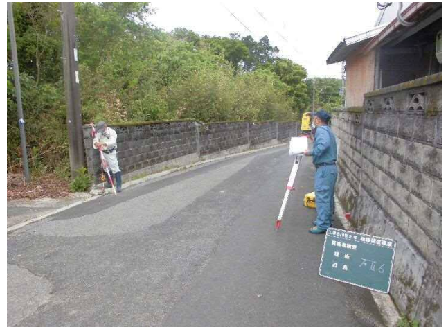
【測量調査状況】
