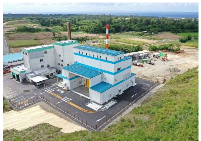
【新しい喜界町クリーンセンター】
