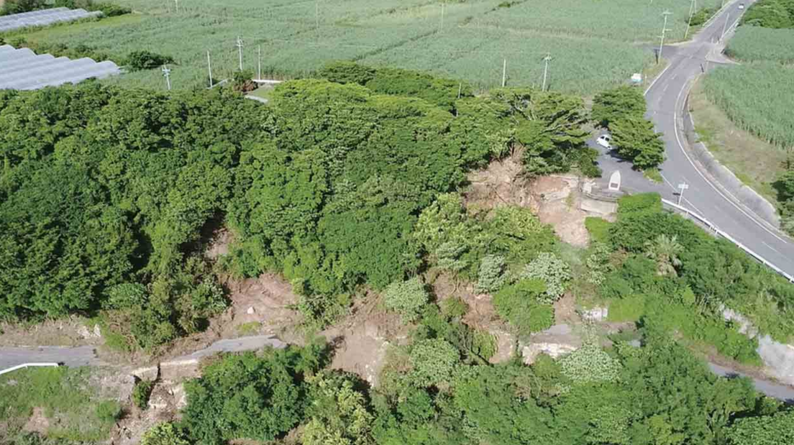
斜面が大きく崩れているムチャ加那公園
