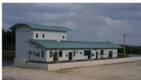
荒木農業集落排水処理施設
