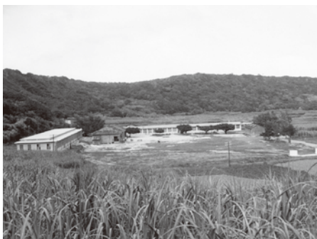
校舎は鉄筋コンクリートに（昭和33年）
