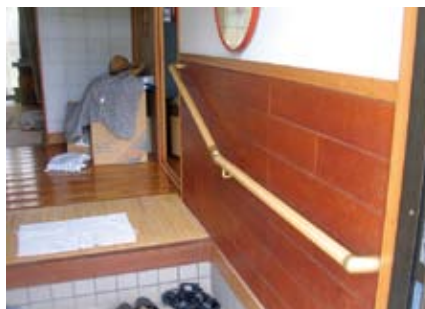
玄関の手すり
