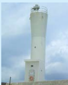
湾港北防波堤灯台2
