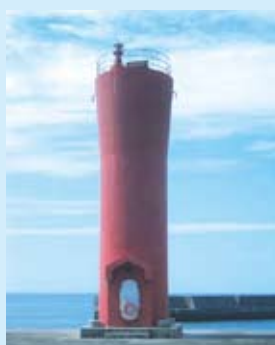
早町港東防波堤灯台
