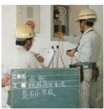
荒木小での点検作業
