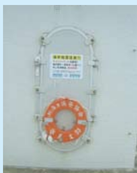
湾港北防波堤灯台
