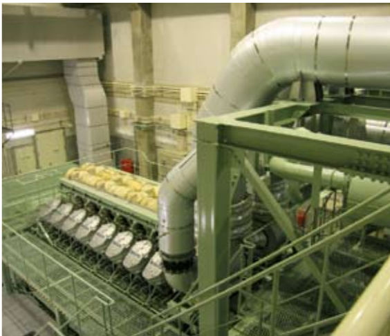
V型16気筒の巨大エンジンが唸る（出力4500kw）
