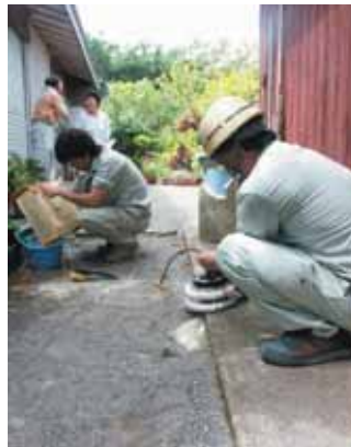
大福電設(独居老人の電気点検・洗浄)
