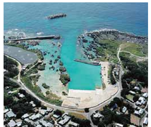
奄振事業で整備が進む荒木漁港
