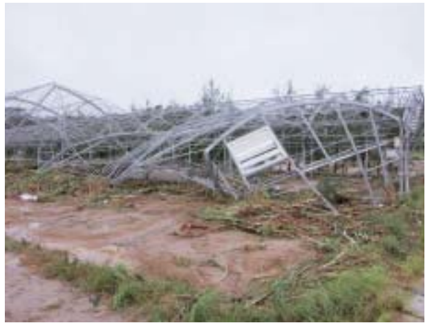
◀ 高潮で押しつぶれた 阿伝消防車庫
