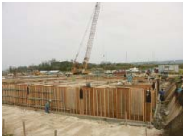
着々と進む新庁舎建設
