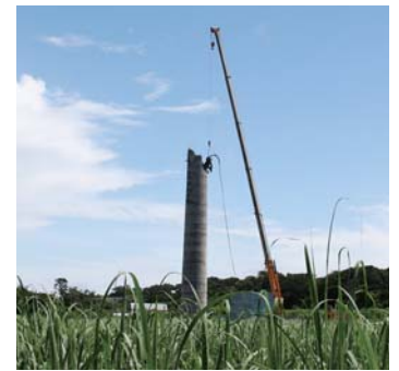
解体途中の煙突 (7月6日)
