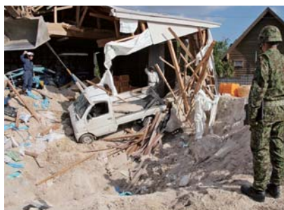
大きな穴が開いた被災現場
