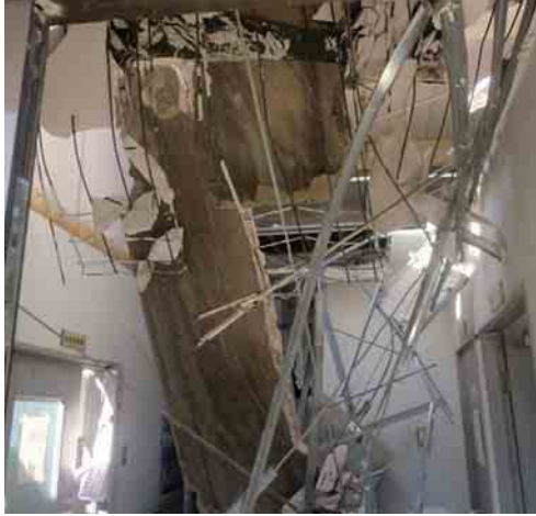
落下物により天井が崩れ落ちたクリーンセンター事務室と壁が破損した建屋
