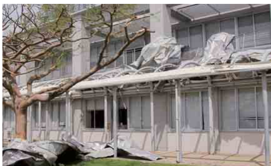
コミュニティセンターの屋根がはがれ役場庁舎に飛散
