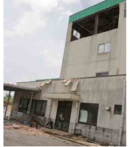
落下物により天井が崩れ落ちたクリーンセンター事務室と壁が破損した建屋
