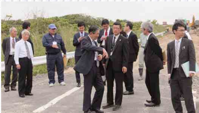
災害復旧工事中のさとうきびの一本道にて
