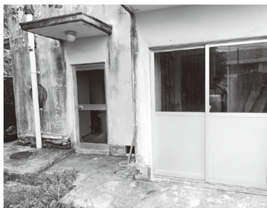
改修工事を待つ避難所となる集落公民館
