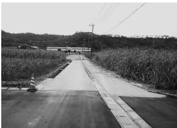
早町小前道路改良工事
