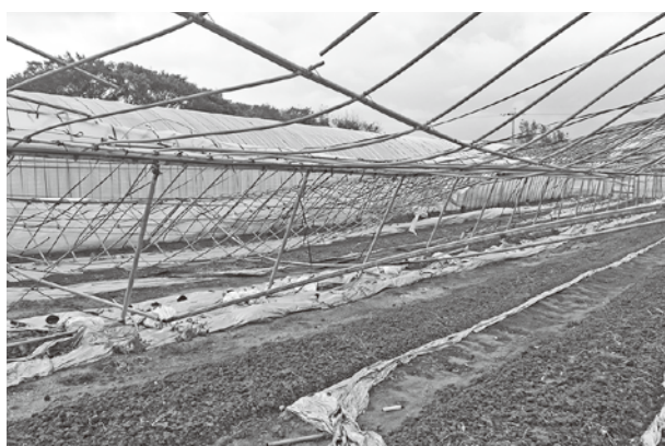
台風によるハウス倒壊
