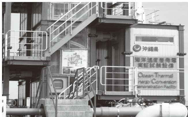
海洋深層水を活用した発電施設
