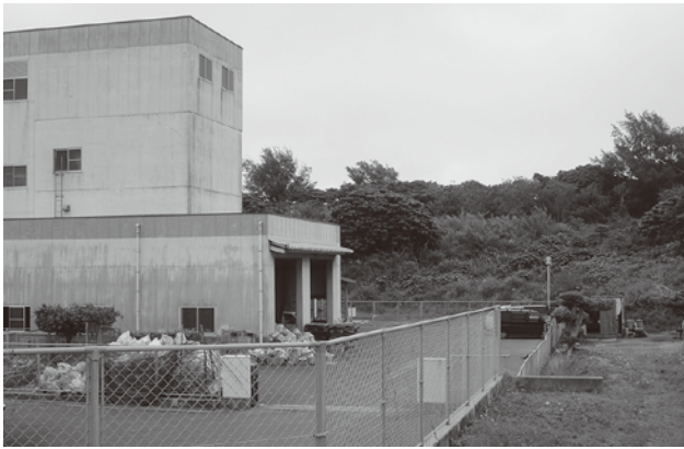
段ボールストックヤード(クリーンセンター隣に予定)
