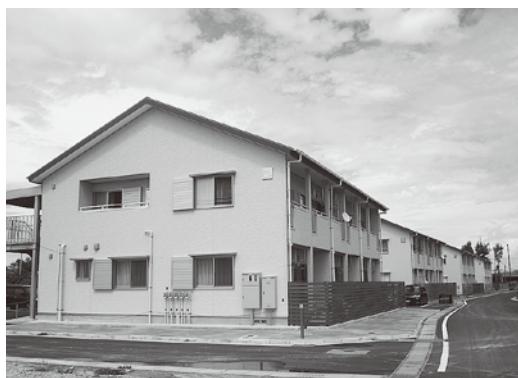
平成27年度公営住宅整備事業(湾宮戸団地D棟) 総額 91,584千円
