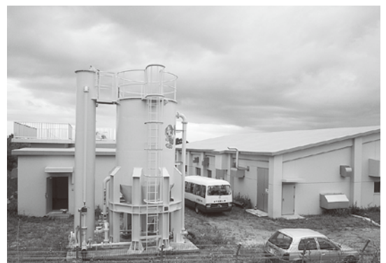
西部浄水場施設工事費(電気・機械整備含む) 総額 576,225千円
