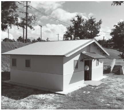
総合グラウンド改修工事(トイレ棟新設ナイト照明改修等) 総額57,520千円
