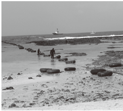
海底光ファイバー敷設工事 総額1,364,484千円
